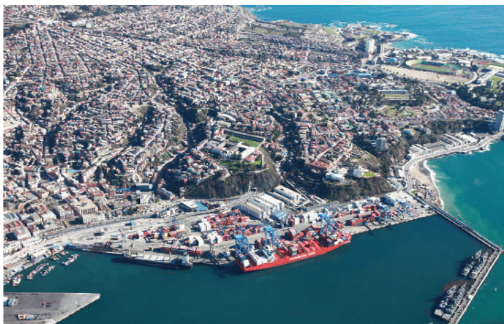
Terminal Pacífico Sur en Valparaíso (Chile)
